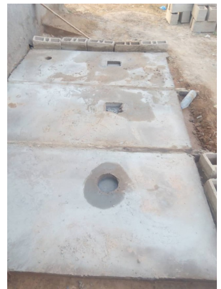
Les toilettes en construction à la maternelle
